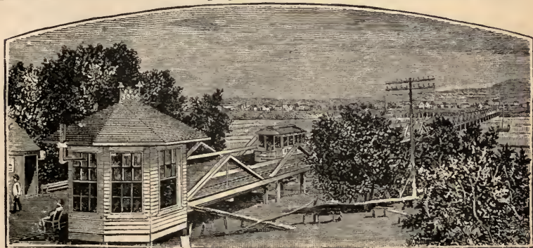
UNI PUENTE INTERNACIONAL—Ciudad Juárez y El Paso ®
